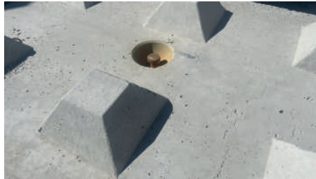
Ancre de levage
