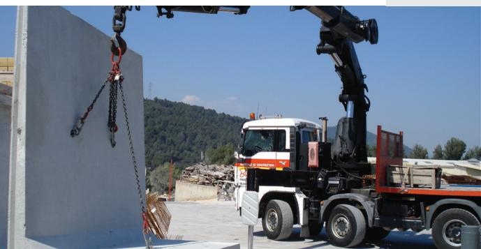
Le «**MUR DE SOUTÈNEMENT EN L**» est réalisé en Béton de type C25/30, en finition lisse, et peut être fabriqué sur commande en béton coloré.
