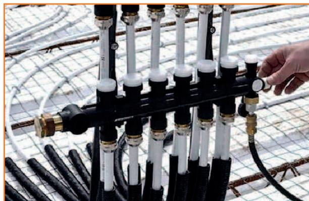
**5** Mise en pression de l'installation à plus de 3 bars. Pose du ferrailage complémentaire et coulage de la dalle de compression.
